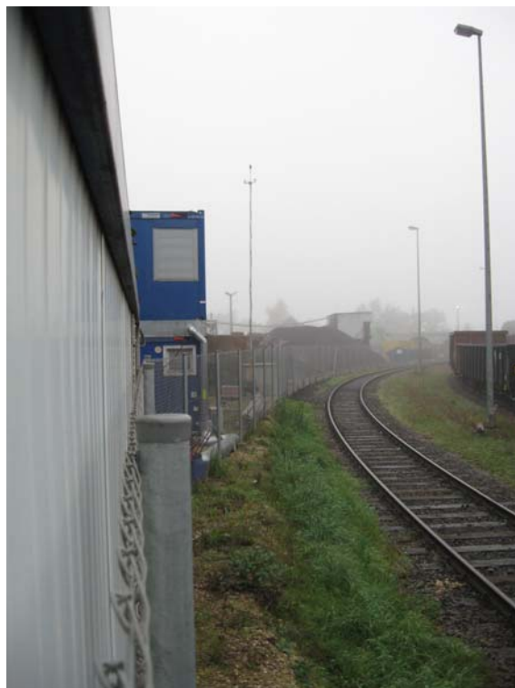
Bild 2.3: Messort MP 50, Werksgeländegrenze
